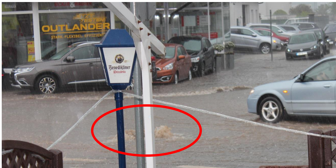
Bild 1: Wasser sprudelt durch den Kanaldeckel auf die Straße.
